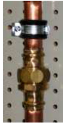
Kupferrohr-Pressverbindung, beidseitig verpresst oder mit einseitiger Gewindeverbindung.
