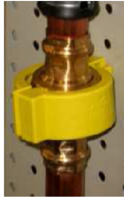
Kupferrohr-Pressverbindung, beidseitig verpresst oder mit einseitiger Gewindeverbindung.
